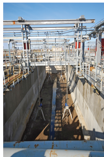
Рис. 9. Аноксидный реактор с механическим перемешиванием иловой суспензии, оснащенный придонными пропеллерными перемешивающими устройствами (ООО «Киниф», г. Кириши).
