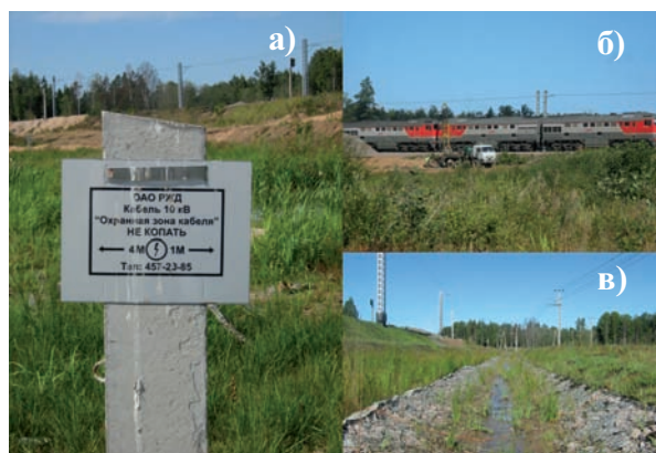
Рис. 4. Источники техногенных помех в полосе отвода железной дороги: (а) кабель высокого напряжения; (б) железнодорожные составы; (в) металлические конструкции.
