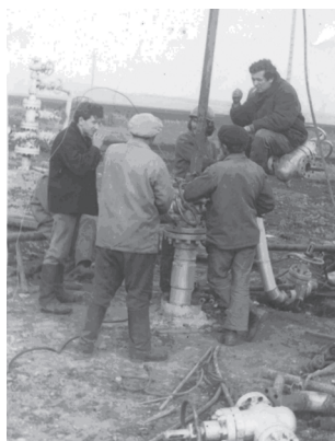
Рис. 1. Первые опыты виброакустических исследований кондуктора скважины.
