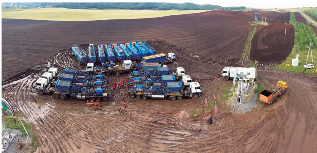
Рис. 5. Проведение массивного ГРП на скважине №21753.
