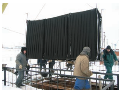
Рис. 7. Установка блока с носителем «Шлейф-1» на очистных сооружениях Константиновского ЛПУМГ.
