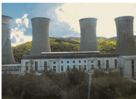
Рис. 2. Геотермальная электростанция в Лардерелло, Италия (Фото В. Сваловой).
