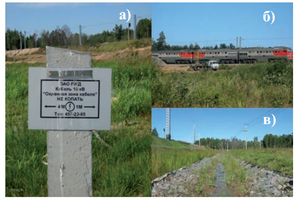
Рис. 4. Источники техногенных помех в полосе отвода железной дороги: (а) кабель высокого напряжения; (б) железнодорожные составы; (в) металлические конструкции.
