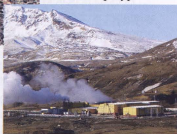
Рис. 9. Мутновская геотермальная электростанция (МВт т ).
